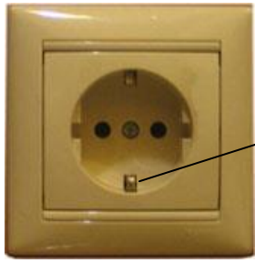
Рис. 2.1. Настенная розетка с контактом заземления.
